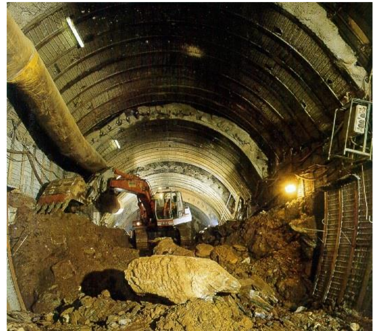
Lockergesteinsvortrieb im Fensterstollen Ferden, Goppenstein
